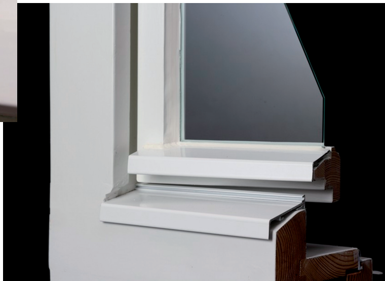
Sanierter Fensterflügel - wieder fit für viele Jahre.
